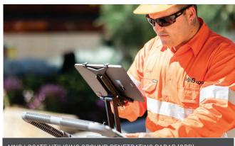
MNG LOCATE UTILISING GROUND PENETRATING RADAR (GPR)
